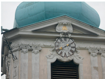
CZ ► Kostel Panny Marie v Horní Políci, detail průčelí vstupní brány v podobě věže – kartuše s monogramem Anny Marie Františky, jež nechala umísťovat na stavby a sochy, které dávala budovat. Stav před rokem 2018 (Foto Martin Aschenbrenner)
