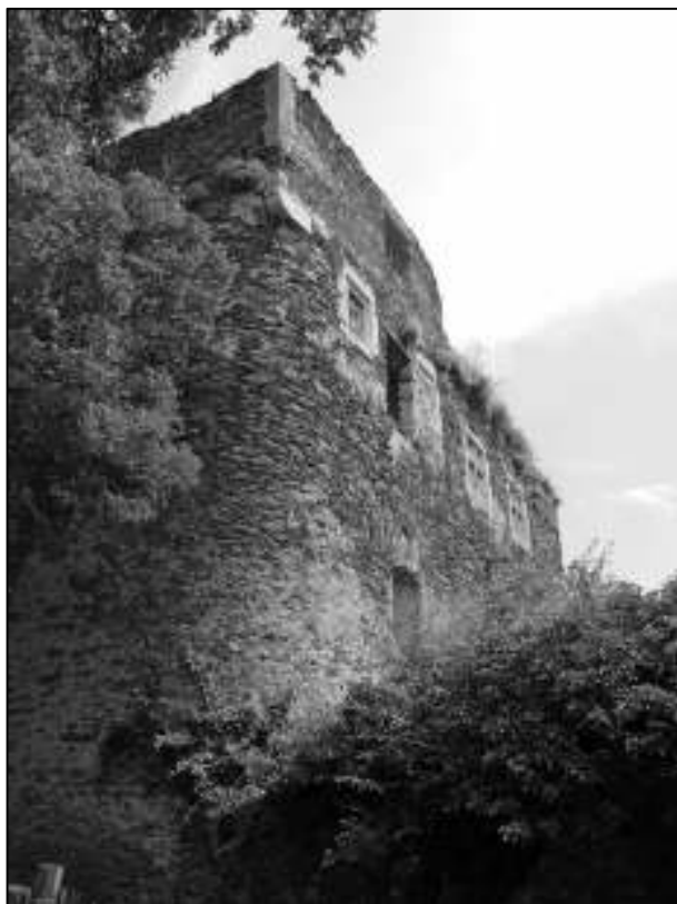
Obr. 49. Nový Hrádek u Znojma, celkový pohled na přední hrad s pozdně gotickými okny v patře (Foto J. Vojta, 2011).
