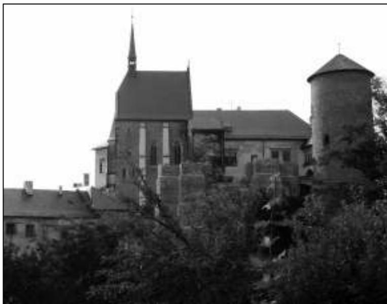
Obr. 20. Hrad Šternberk – celkový pohled na jádro od východu. Vpravo gotický bergfrit, vlevo hradní kaple, před níž předstupuje torzo pozdně gotické věžovité stavby (Foto J. Štětina, 2019).
