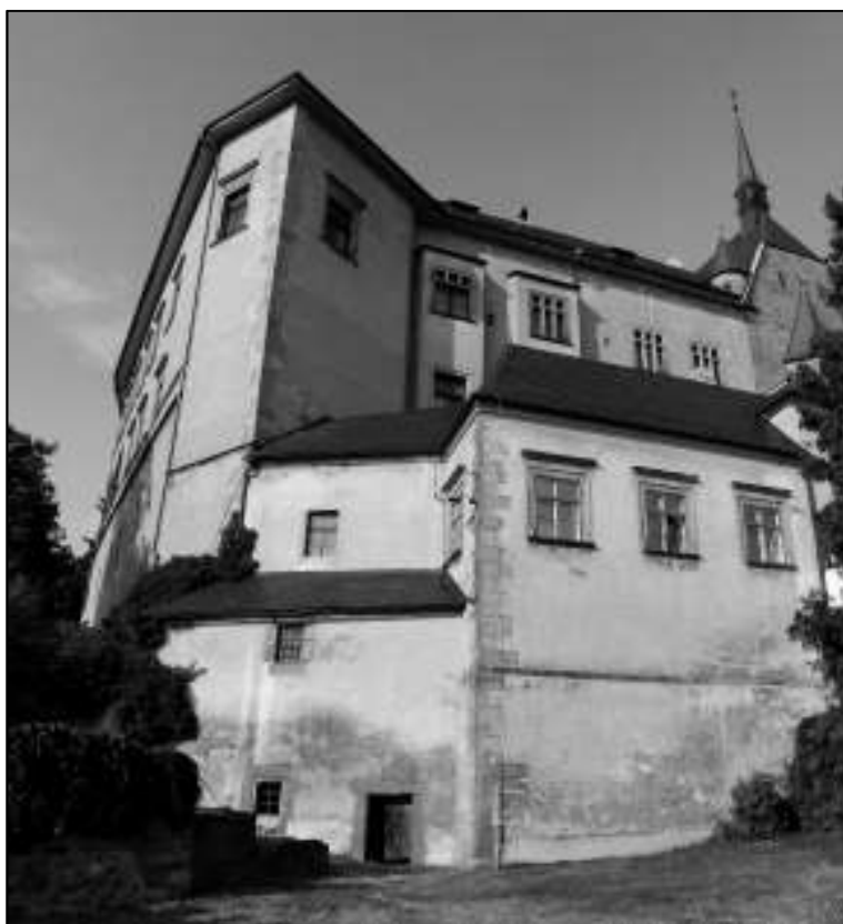
Obr. 33. Hrad Šternberk – jihozápadní nároží hradního jádra s pozdně gotickou nárožní věžicí (vlevo), před níž předstupuje renesanční přízemní budova v jižním parkánu (Foto J. Štětina, 2019).
