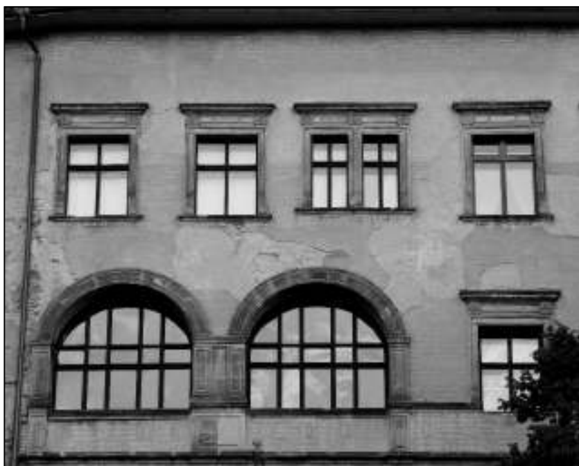
Obr. 30. Hrad Šternberk – část průčelí berkovského traktu v úrovni prvního a druhého patra s dominantním motivem arkádové lodžie tzv. Vizitkového sálu (Foto J. Štětina, 2019).
