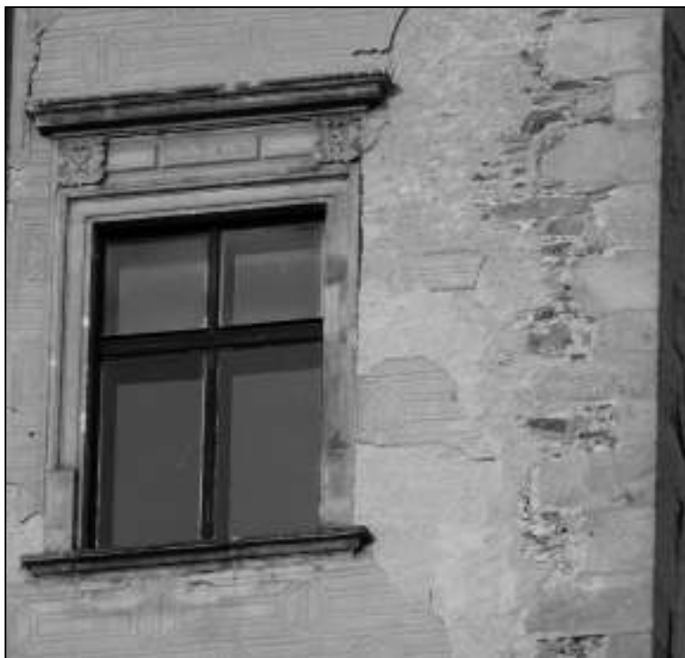
Obr. 38. Hrad Šternberk – okenní ostění v nárožní místnosti druhého patra berkovského traktu s heraldickou výzdobou v kazetovaném nadpraží, 1560. Vpravo kvádrové nároží pozdně gotické věžice při jihozápadním nároží paláce (Foto J. Štětina, 2019).
