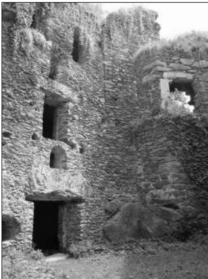
Obr. 48. Nový Hrádek u Znojma, přední hrad, část nádvorního průčelí (Foto J. Vojta, 2011).
