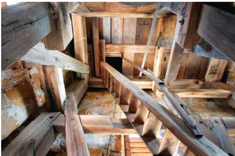
Věž – pohled na strop zvonice
