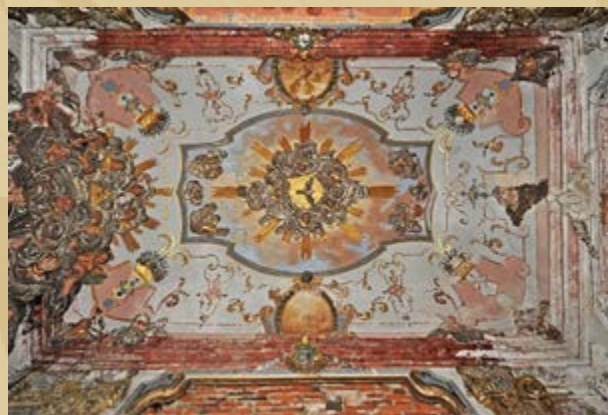
Štuková výzdoba stropu kaple na zámku v Kácově
